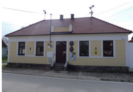
Budova obecního úřadu květen 2019
