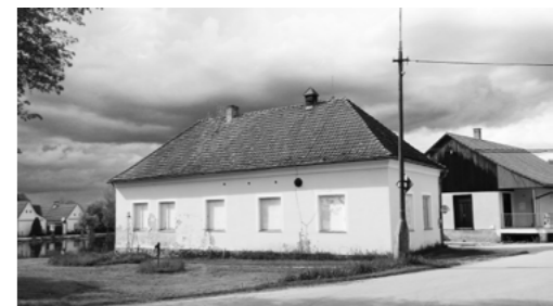
Budova zpracovny uzenin na návsi
