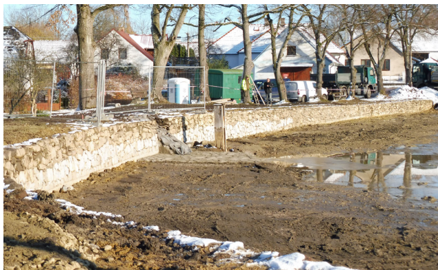
Oprava hráze rybníku Horní návesní Financováno v rámci NEXT GENERATION EU
