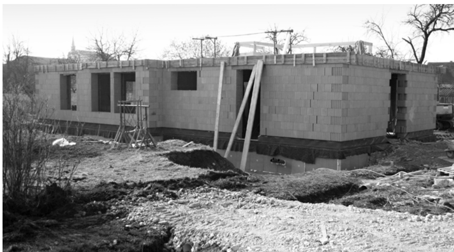
Foto: Aktuální výstavba chráněného domu v Lomnici nad Lužnicí
